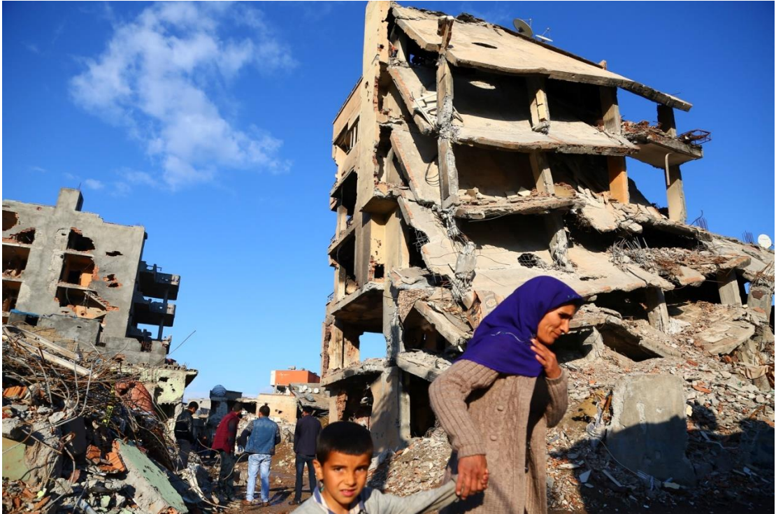
Vahşet Bodrumlarının olduğu sokaklar...Yıkım hali büyük bir deprem sonrasını andırıyor.
