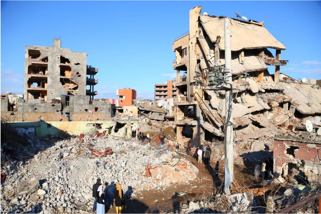
Üçüncü Vahşet Bodrumunun yanında bulunan bir cami saldırılar nedeni ile enkaza dönüştü.
