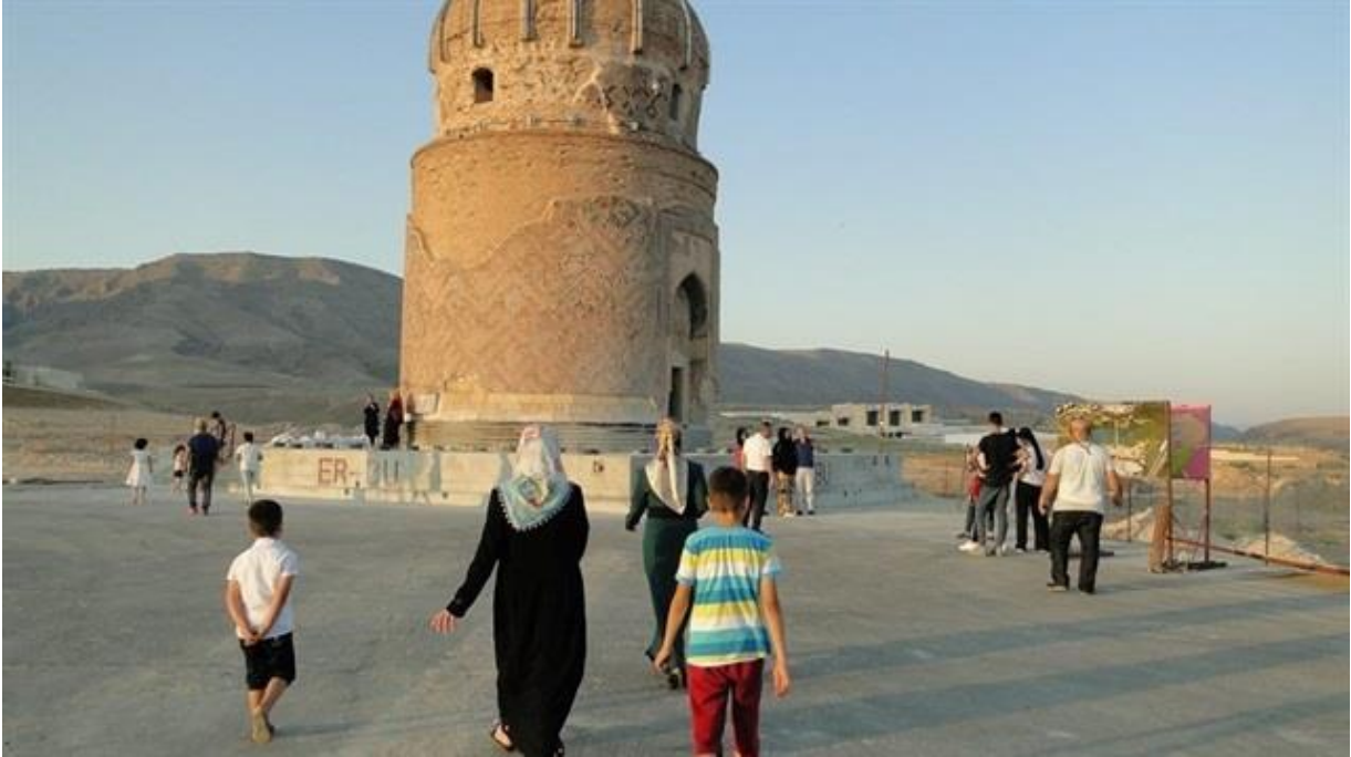
Betona Teslim Edilmiş Zeynel Bey Türbesi
