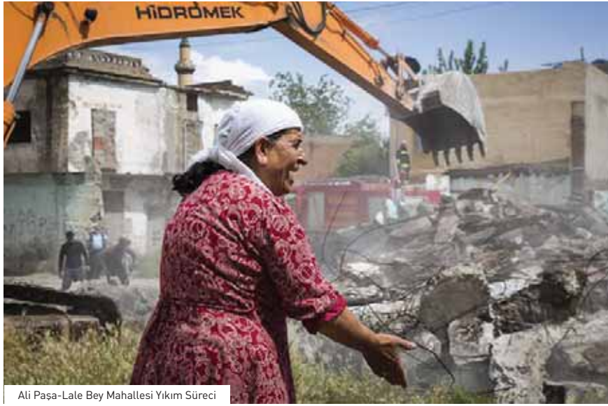
Ali Paşa-Lale Bey Mahallesi Yıkım Süreci
